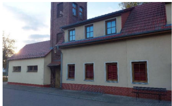
Gebäude der Freiwilligen Feuerwehr mit Gemeindesaal in Lugau
