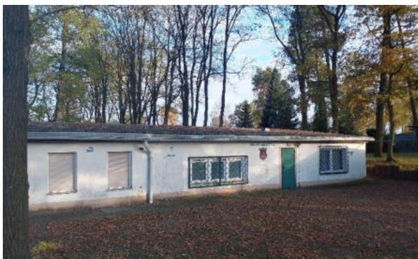
Gebäude des Schützenvereins Rückersdorf
